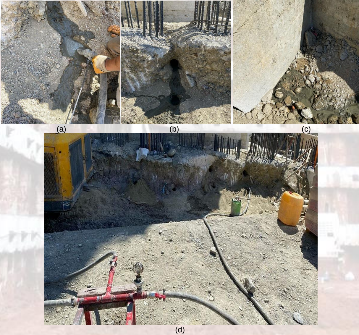
Şekil 18. Ağaogulları İnşaat Zemin Enjeksiyonu (a, b, c, d) (Ankara, 2021)
