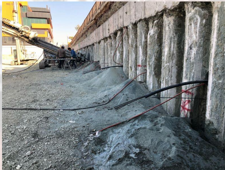
Şekil 15. BKS Cam Balkon Hizmet Binası Geçici Öngermeli Zemin Ankraji Uygulaması (Ankara, 2021)
