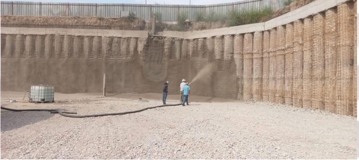
Şekil 19. Bursa Fabrika İksa Önü Koruma Kuru Shotcrete Uygulaması (Bursa, 2022)
