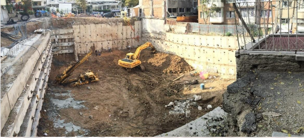
Şekil 16. BTC İnşaat Kızılay Oteli Ankrajlı Perde Uygulaması (Ankara, 2016)
