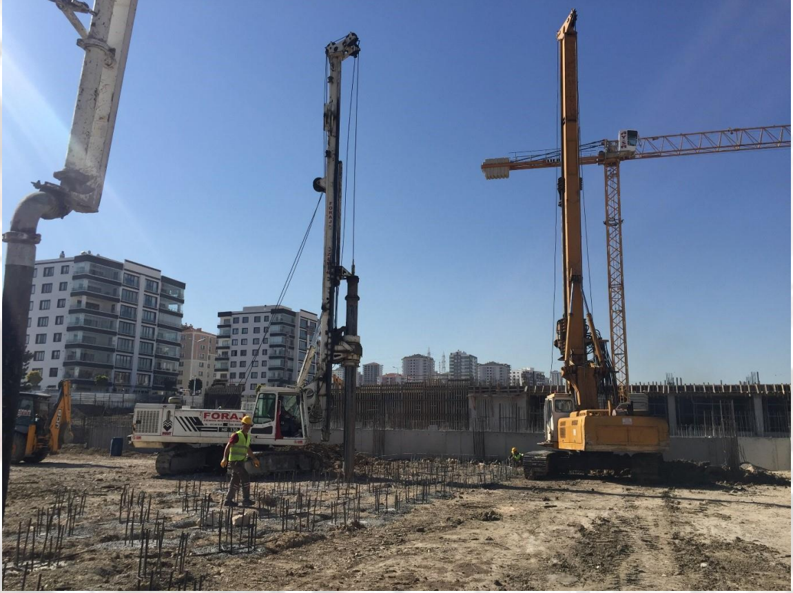
Şekil 9. T.C. Aile ve Sosyal Hizmetler Bakanlığı Sosyal Tesisleri Temelaltı Fore Kazık Uygulaması (Ankara, 2019)
