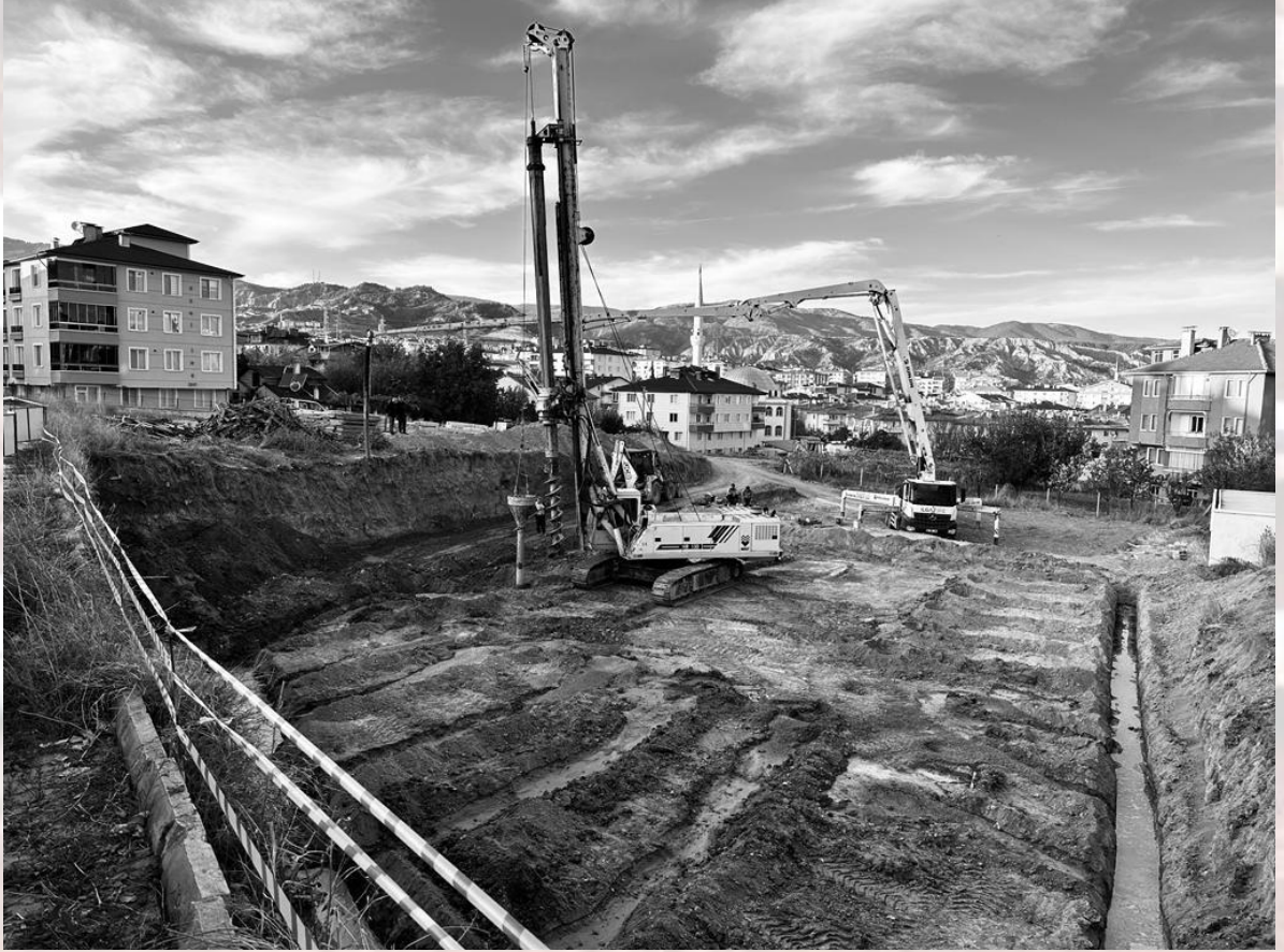
Şekil 1. 50 cm Temelaltı Fore Kazık Uygulaması (Kastamonu, 2023)
