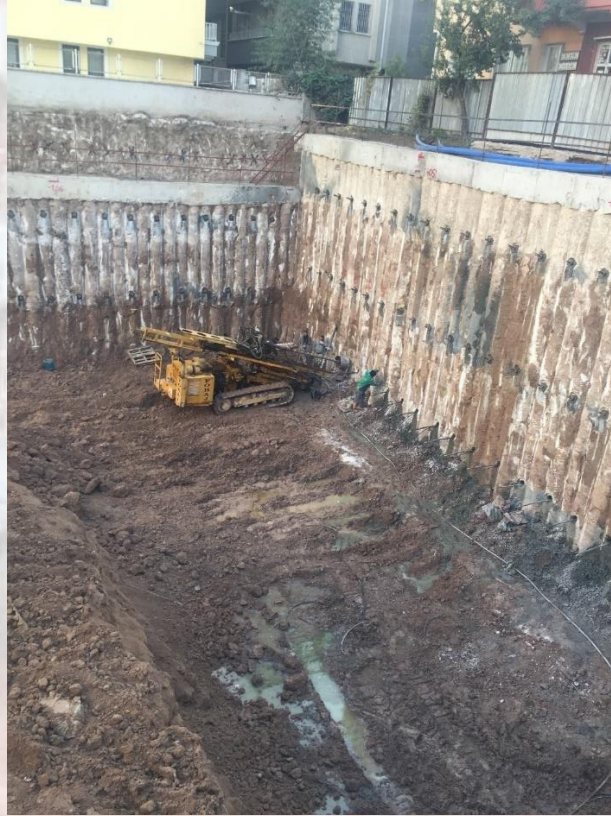
Şekil 17. Başkent Hastanesi Ek Binası Teğet Kazık ve Öngermeli Geçici Zemin Ankrajı Uygulaması (Ankara, 2018)
