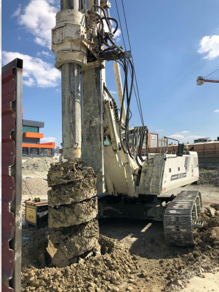
Şekil 2. BKS Cam Balkonları Hizmet Binası 100cm İksa Kazık Uygulaması (Ankara, 2021)
