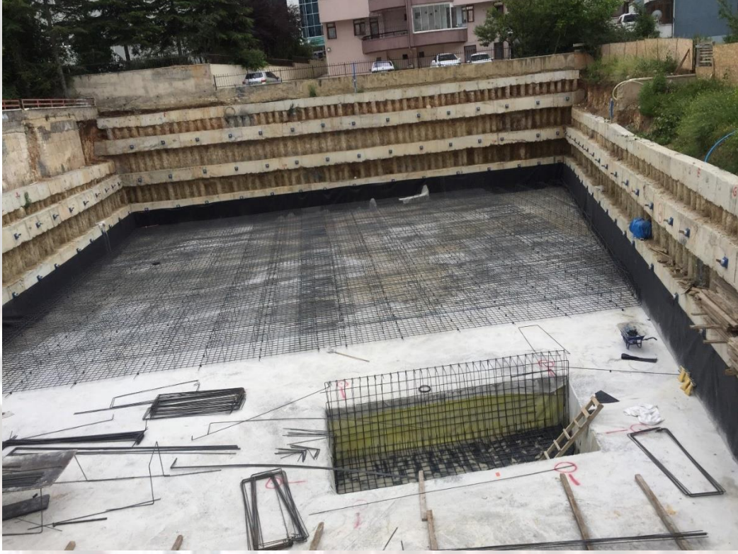
Şekil 12. Sendika Binası Mini Kazıklı İksa Sistem Uygulaması (Ankara, 2019)
