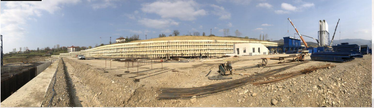
Şekil 3. MESCİER Fabrikası Fore Kazık ve Kalıcı Ankraj Uygulaması (Bartın, 2020)
