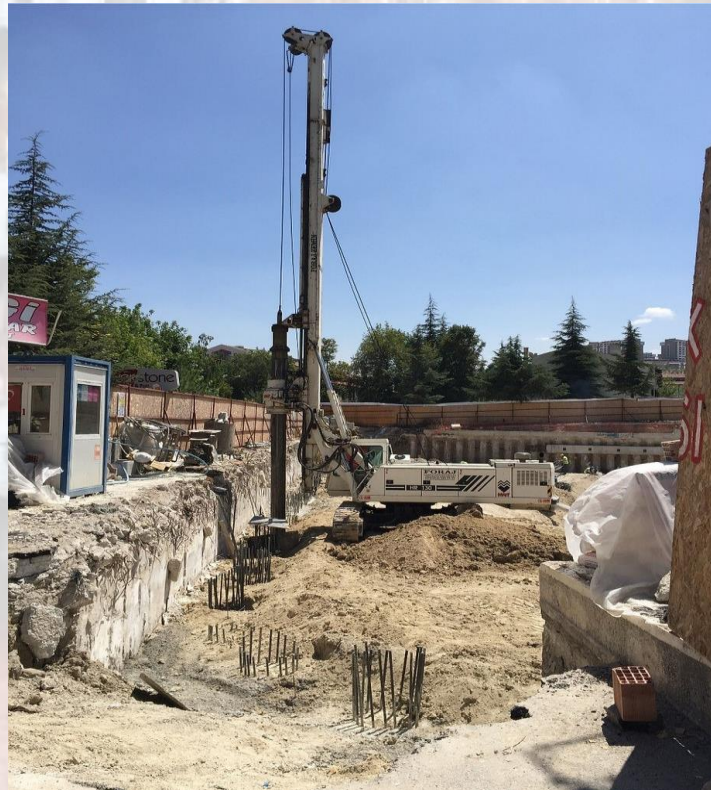
Şekil 6. Galleria AVM 80cm İksa Kazıkları (2017, Ankara)
