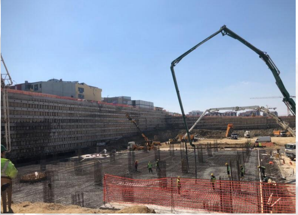
Şekil 5. OTOKENT Galeri AVM İksa Uygulaması (Ankara, 2020)
