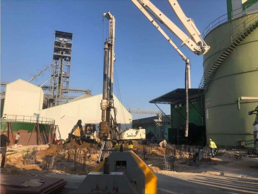
Şekil 8. PROYEM Melas Silo Altı Fore Kazık Uygulaması (Manisa, 2023)
