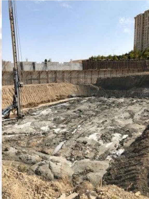
Şekil 20. Kooperatif Evleri Temelaltı Jet Grout Uygulaması (Ankara, 2021)
