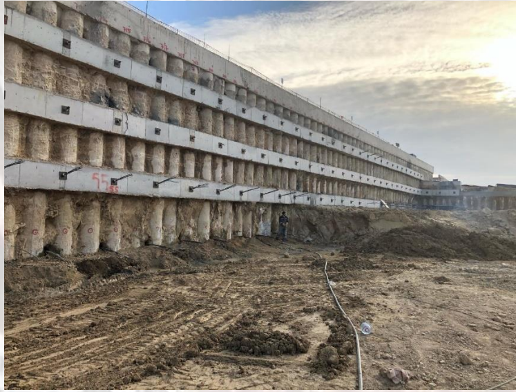
Şekil 14. OTOKENT Galeri AVM Öngermeli Geçici Zemin Ankraji Uygulması (Ankara, 2020)
